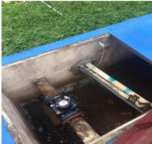
*Figura 56. Construcción de cableado del medidor hacia el sistema*
