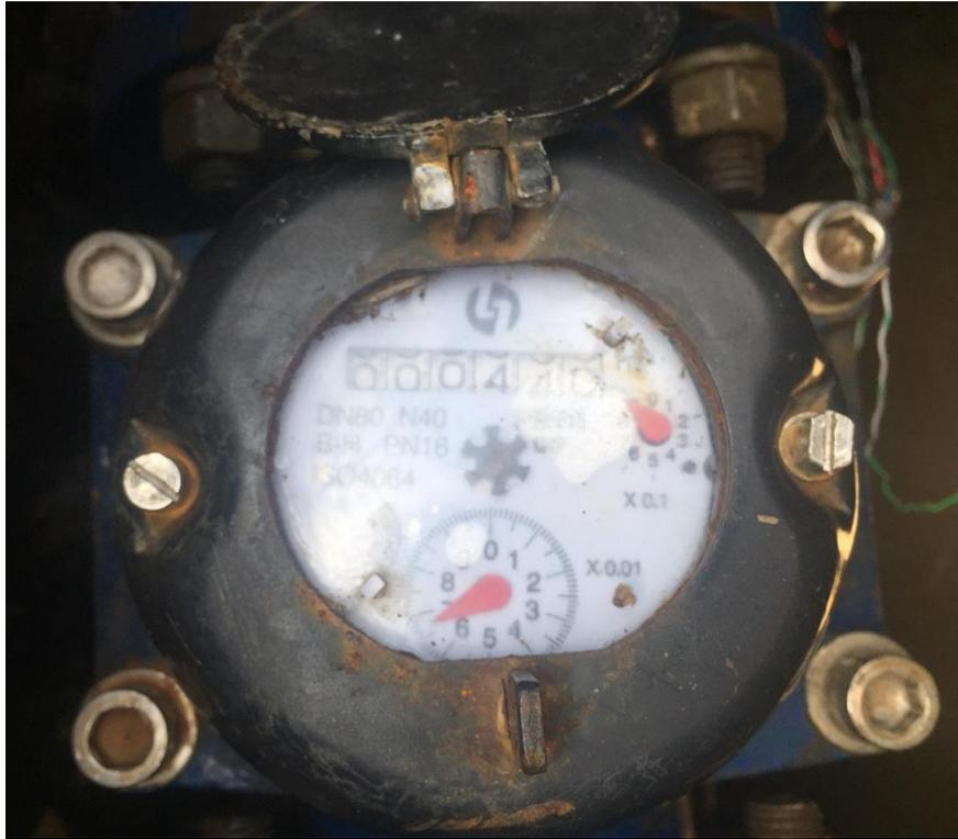
*Figura 70. Sensor magnético inactivo.*
