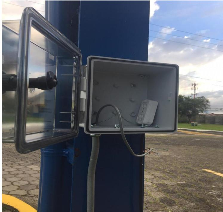
*Figura 55. Instalación de la caja del sistema programable*
