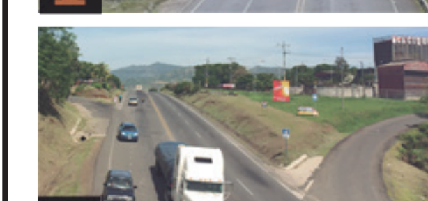
1 AUTOPISTA BERNARDO SOTO
