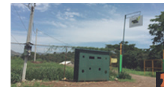
2 CENTRO DE ACOPIO
