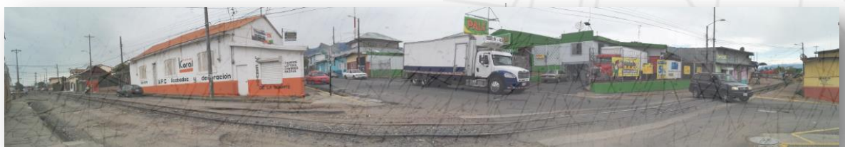
IMG #24. Fachada Sur Actual
