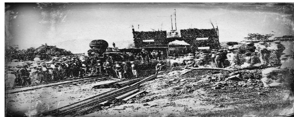
IMG #7. Fotografía luego de l terremoto
