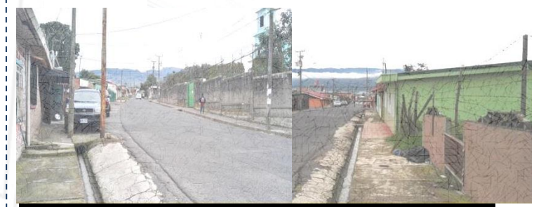
IMG #23. Fachada Oeste Actual
