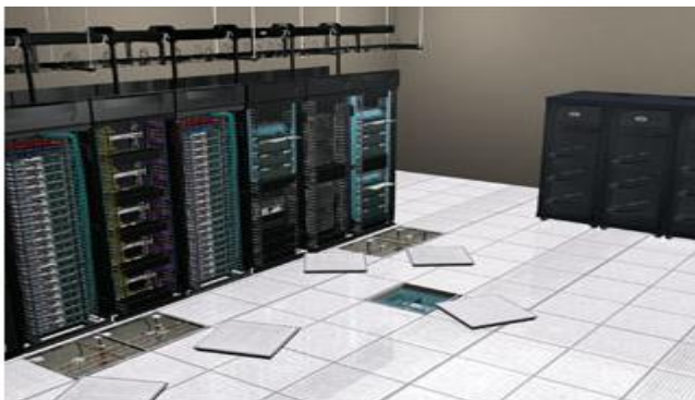
Figura 8. Piso Falso. (Panduit, 2016).
