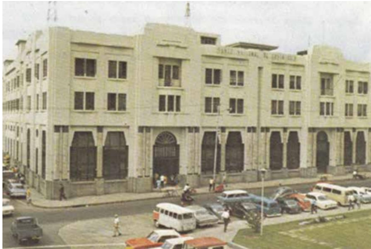
Imagen 2 El edificio del Banco Nacional de Costa Rica en 1976
