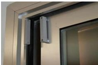
Figura 11 Sistema de sensor de cierre magnético
