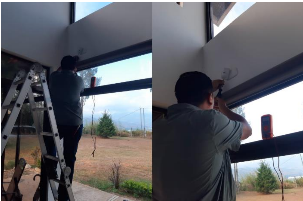
Figura 43 Instalación de sensor PIR.
