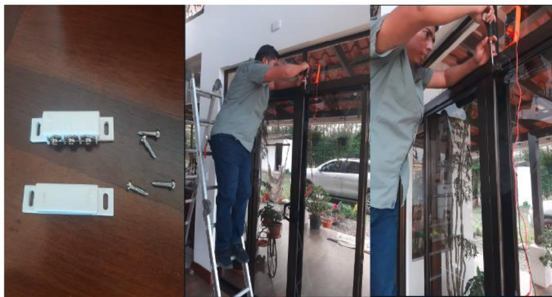
Figura 42 Instalación de sensor magnético.
