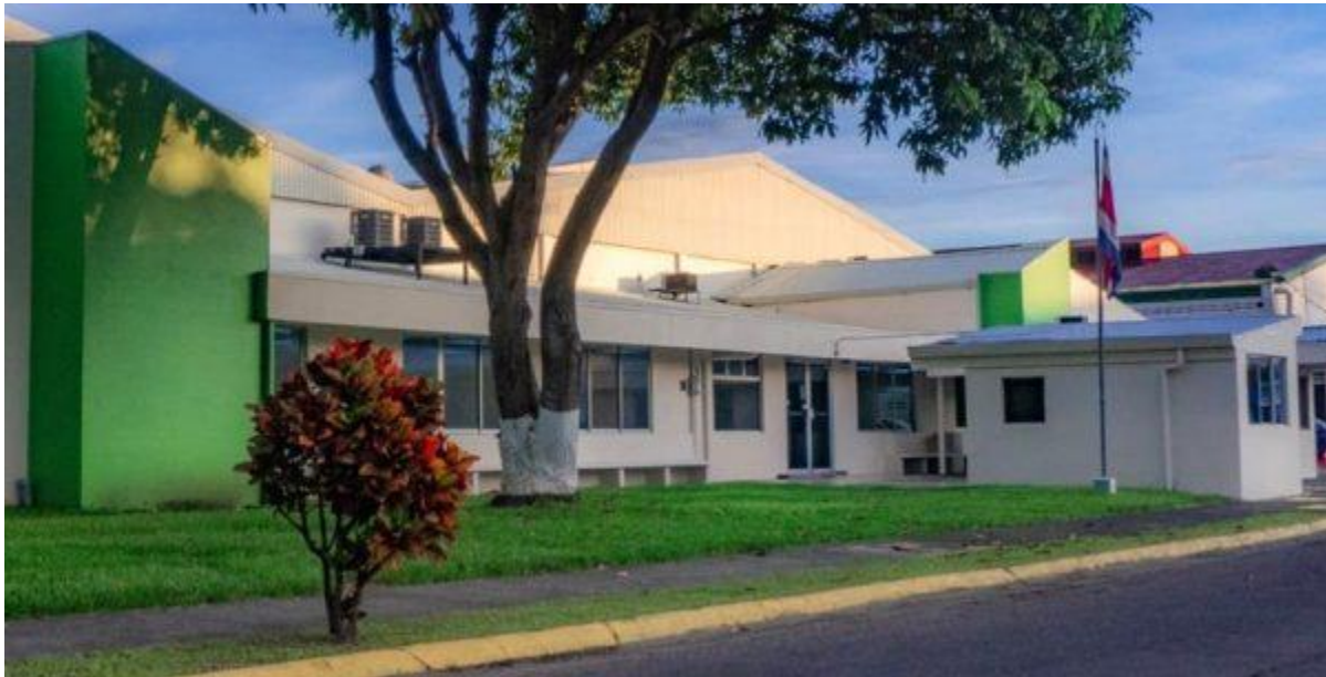
Figura 1. Instalaciones centrales de Microbiología y Calidad Industrial.
