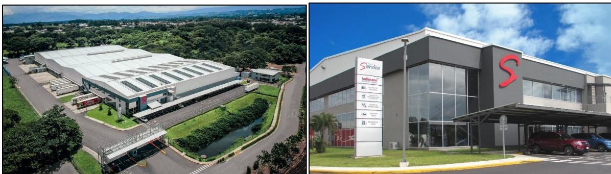
Figura N° 15: Infraestructura y planta del Grupo Servica
