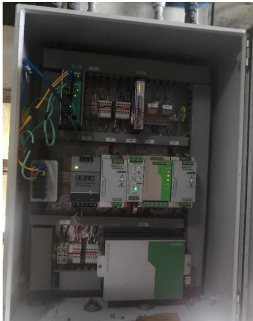
*Ilustración 29- Gabinete de comunicación Zona Espuma.*
