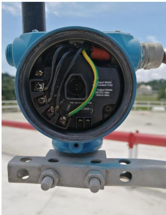
*Ilustración 26- Conexión del transmisor discreto 702.*
