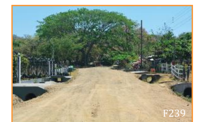
Carretera Distrital Fuente: Municipalidad Carrillo
