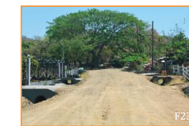
Carretera Distrital Fuente: Municipalidad Carrillo
