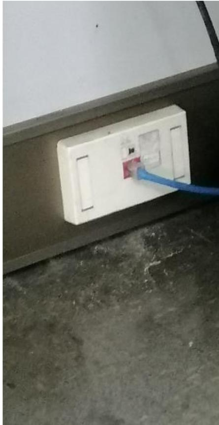
Se puede observar un poco de desorden de cables, además de diferentes tipos sin ningún etiquetado, lo que indica que el mantenimiento es mínimo, en la imagen se puede visualizar mucho polvo en la superficie de los equipos, todos los artefactos están conectados a una sola terminal, sin embargo, se rescata que los equipos cuentan con UPS, por lo que al haber un corte de corriente los funcionarios tienen la posibilidad de guardar la información.
