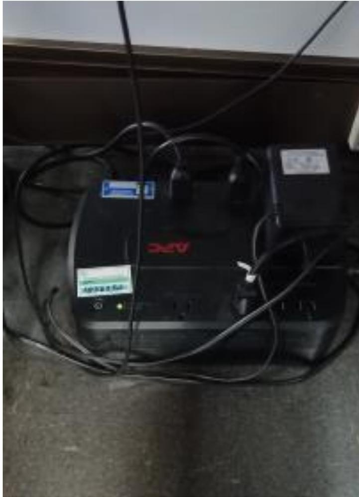
La instalación de los equipos en los puestos de trabajo muestra los cables expuestos, enredados, no hay aseo por parte de los colaboradores según la imagen anterior, al consultar acerca del escaso mantenimiento que se observa en cada equipo comentan que el tiempo que dedican para realizar estas funciones es mínimo, por lo que el mantenimiento queda sin reparación hasta que ocurre la falla inminente en los equipos.
