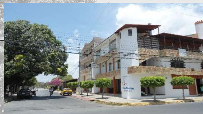
Imagen 80. Zona comercial. Fuente: Propia
