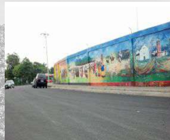
Fi-6 Fuente propia. Sector Norte Estadio Edgardo Baltodano Briceño.
