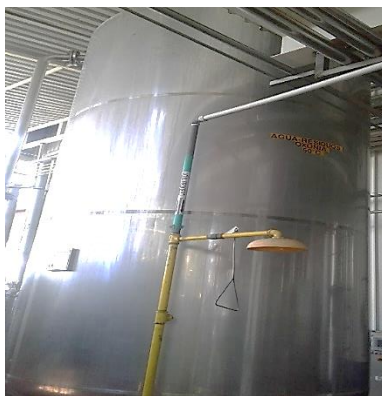
Figura 4: Depósito Almacenador de aguas residuales.
